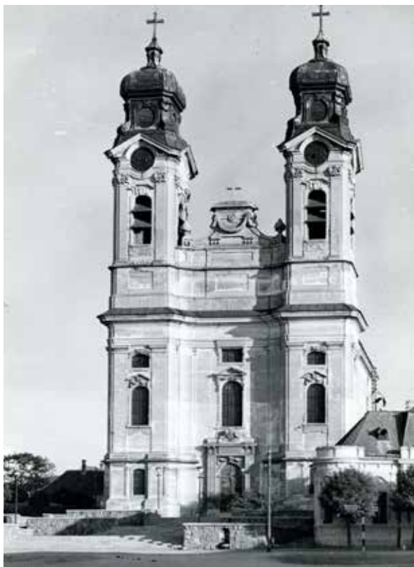
A plébániatemplom főhomlokzata a tér felől nézve
