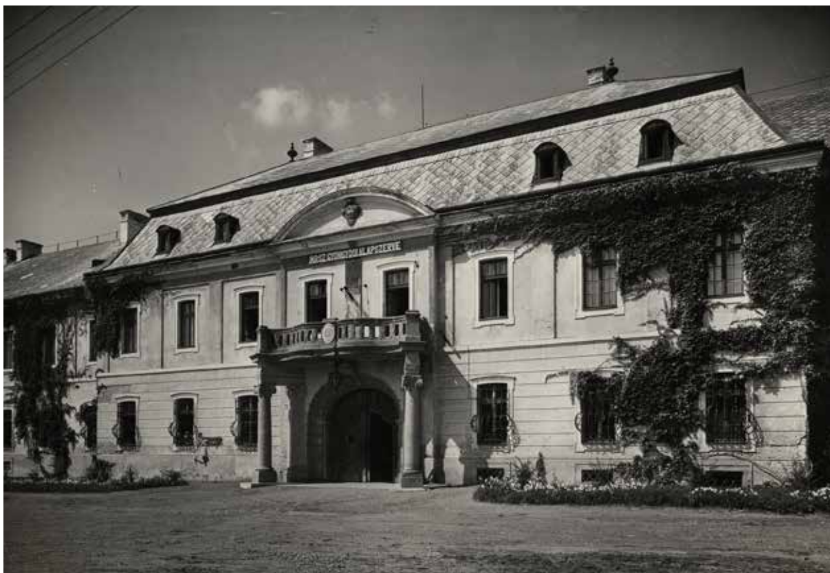
A gyöngyösi kvártélyház főhomlokzata
