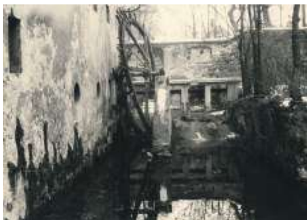
24. kép: A tönkrement vízikerek és a rekesztő, 1978-ban (MÉM MDK Tervtár ltsz.: 14787)
