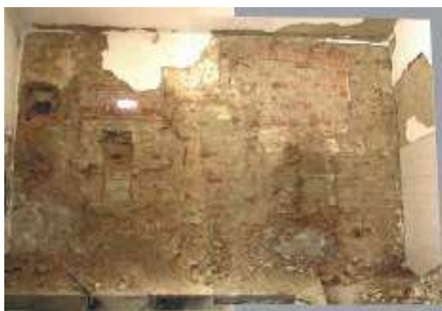
11. kép: A malomtér (1. helyiség) malomárok felé eső fala az őrlőszerkezet átépítéseinek nyomaival (fotó, utómunka: Héczey-Markó Ágnes, 2010)
