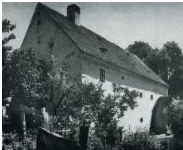
7. kép: A malom főépületének északi, és a csatorna felőli, nyugati homlokzata, 1950-es évek (fotó: Rados Jenő, RADOS 1964, 111. 80. kép)
