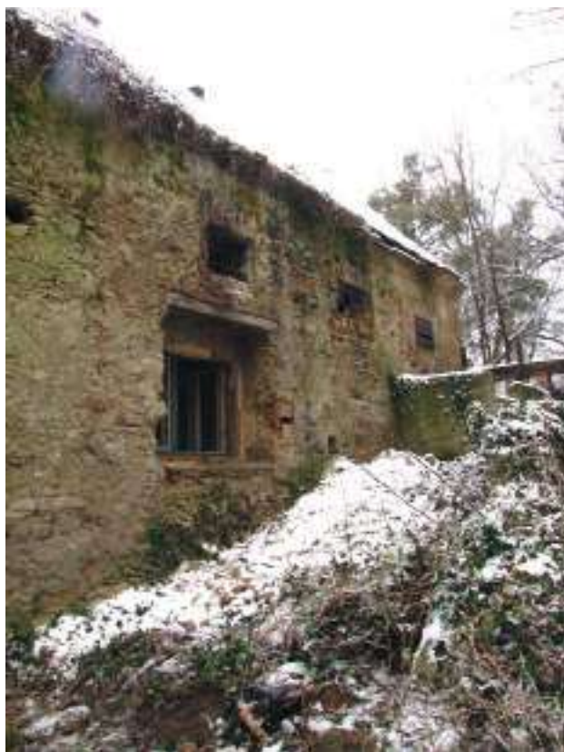
10. kép: A malom délnyugati homlokzata a három tengely helye felett nyíló ablakokkal, balra a molnárlakás fala csatlakozik (fotó: Héczey-Markó Ágnes, 2010)
