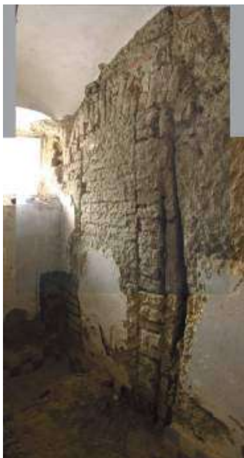
15. kép: A molnárlakás megépítésekor (2. építési periódus) nyitott ajtó a malomház északnyugati falán (fotó, utómunka: Héczey-Markó Ágnes, 2010)
