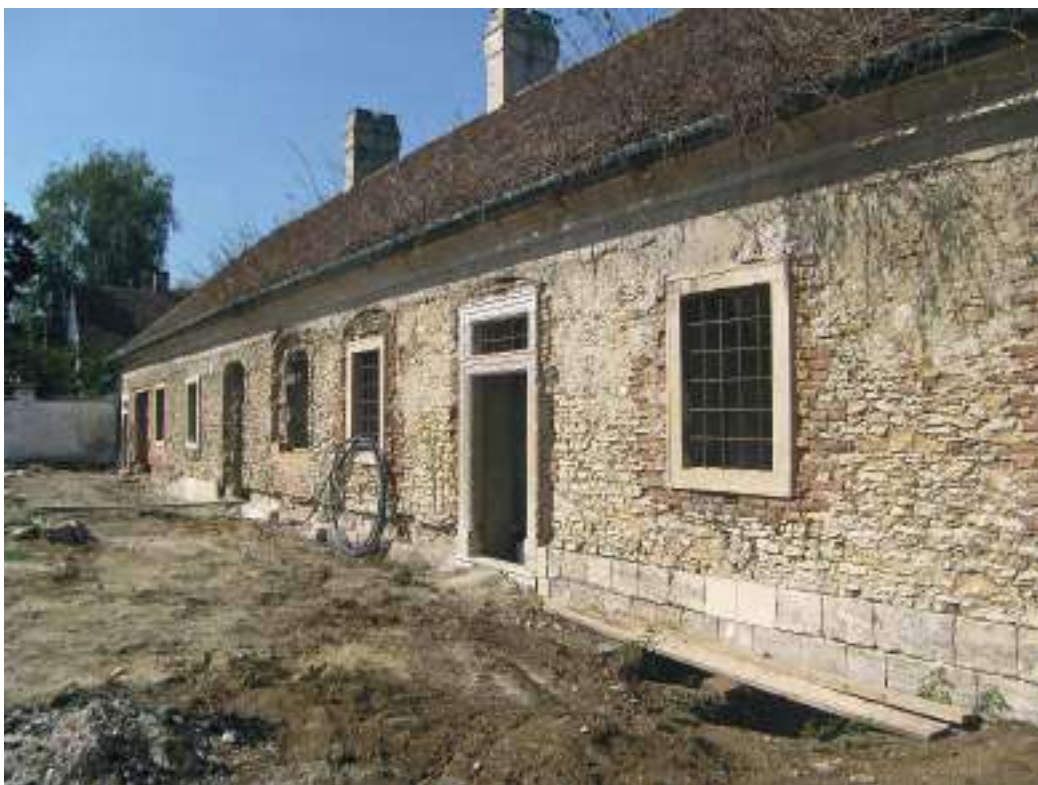
2. kép: Az északnyugati szárny a felújítási munkálatok közben (2012)
