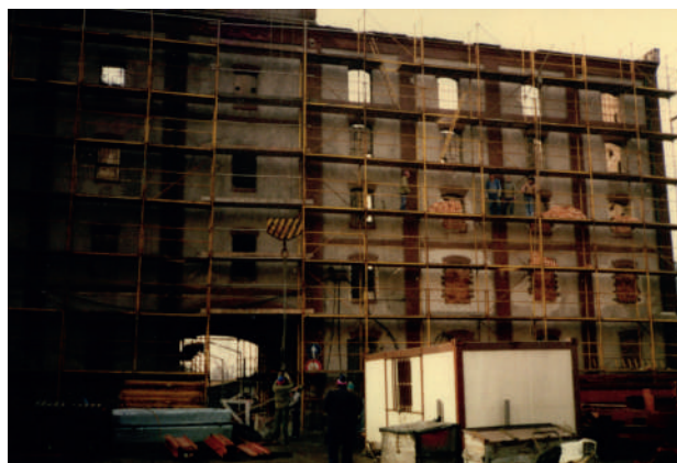
13. kép: Az épülő új malom, 1988. október (Virág Péter gyűjteménye)
