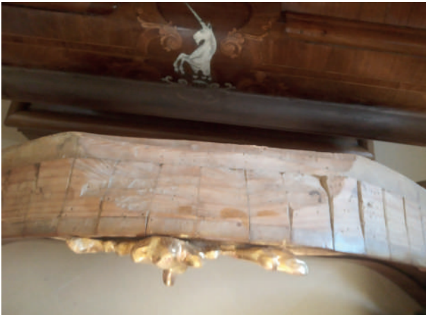
11. kép: Az oltár oromzatának boltozathoz igazított hátsó éle (fotó: Sárossy Péter, 2021) Fig. 11: The rear edge of the pediment of the altar adjusted to the vault (photo: Péter Sárossy, 2021)
