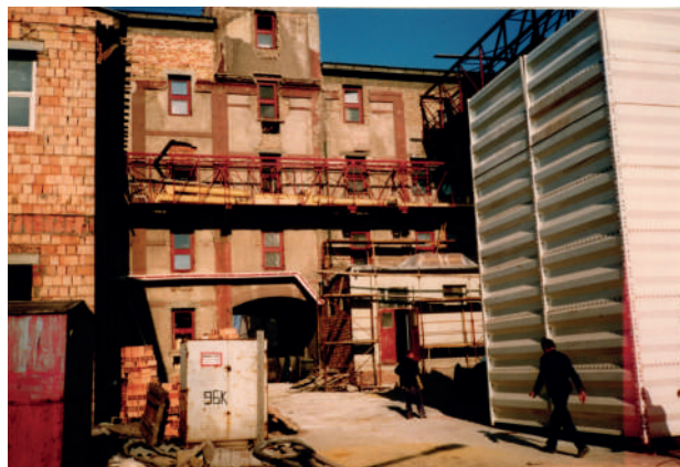
14. kép: Az épülő új malom, 1989. október (Virág Péter gyűjteménye)
