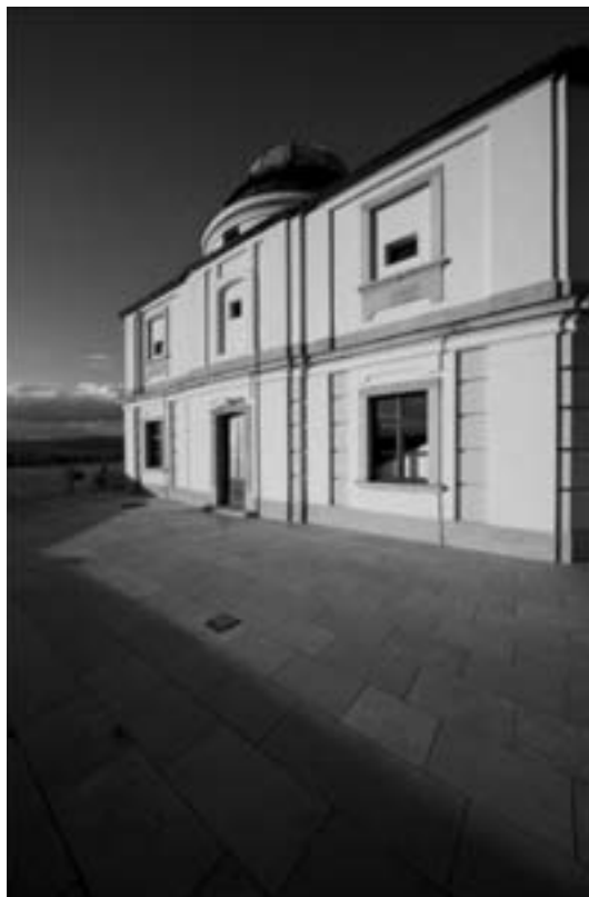
Építmény a toronytetőn a forgókupolával (Építészfórum)
