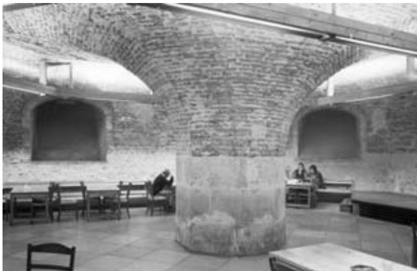
Tartóoszlop a nyugati főhomlokzat pincéjében, 1978 (Fortepan, VÁTI, 31046)
